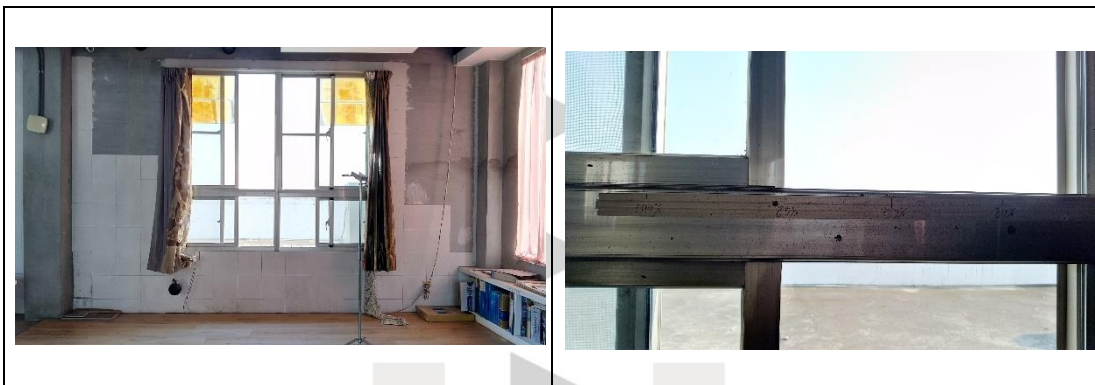
圖 9 開口部開口率 80%現況照片
