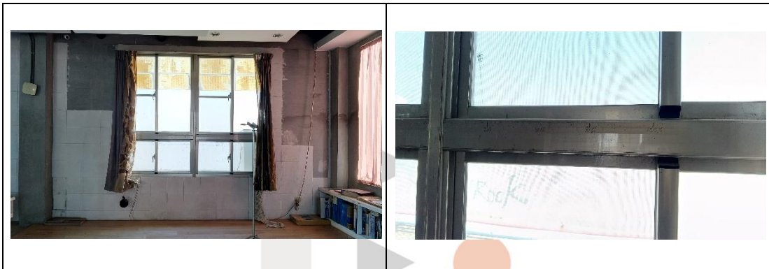
圖 12 開口部開口率 0%現況照片
