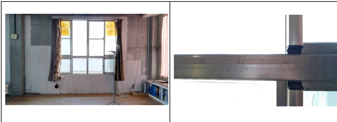
圖 8 開口部開口率 100%現況照片
