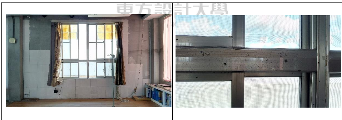
圖 10 開口部開口率 50%現況照片
