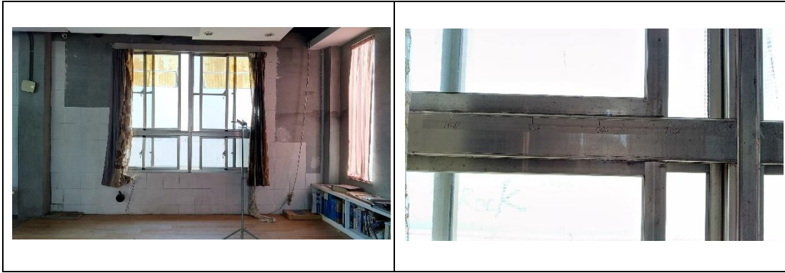
圖 11 開口部開口率 20%現況照片
